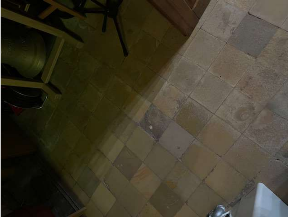
Fot. 9 Widoczne zużycie okładziny z płytek ceramicznych (boczne wejście na ołtarz)
