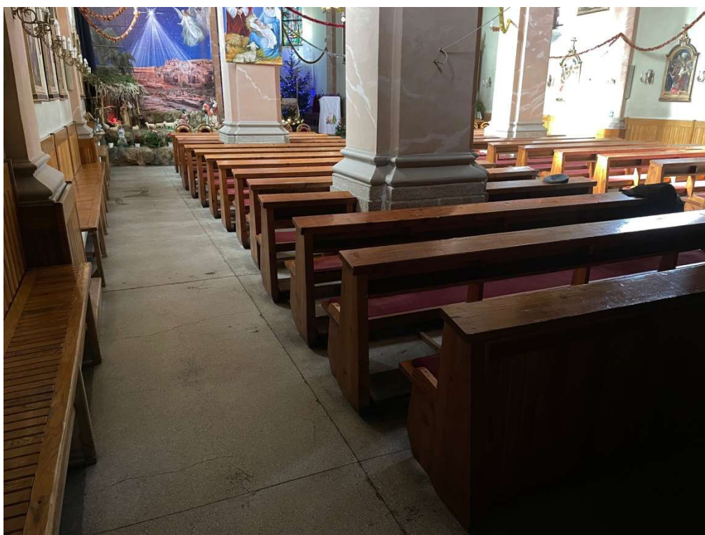
Fot. 3 Widoczne pęknięcia nawierzchni lastryko baczego dojścia do ławek
