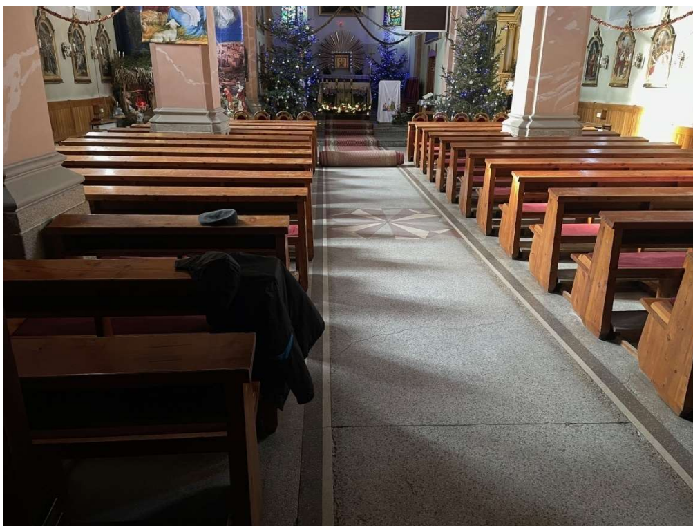
Fot. 3 Widoczne pęknięcia nawierzchni lastryko baczego dojścia do ławek
