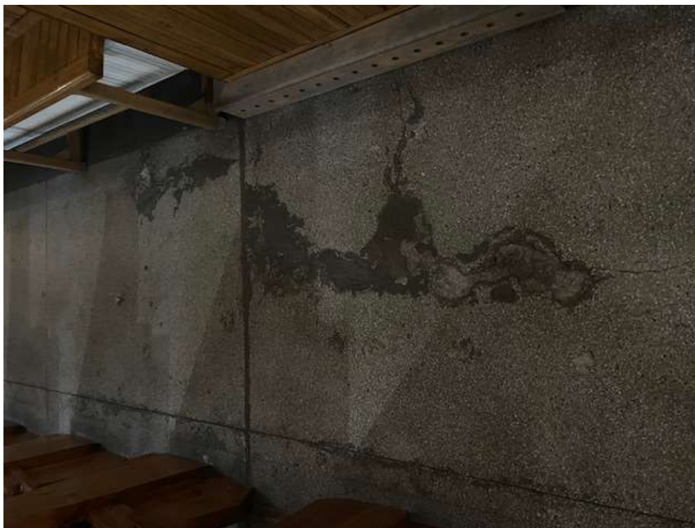
Fot. 5 Widoczne ubytki i późniejsze uzupełnienia betonem
