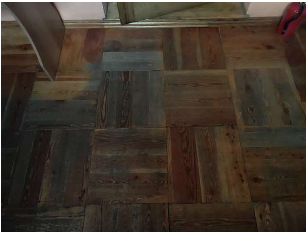
Fot. 7 Widoczne nierówności okładziny podestu wejściowego na ołtarz
